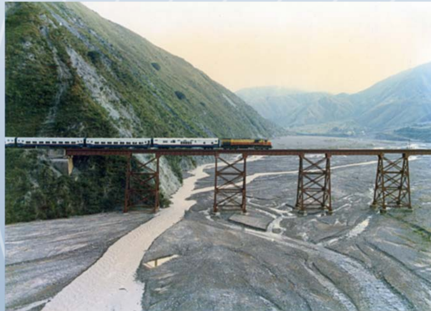
Puente sobre el ríoToro Con el “Tren a las nubes”
